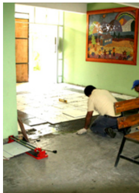
Pose du carrelage dans l'entrée de l'école de Casas Viejas
